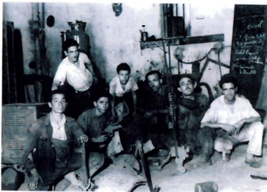
El día de las pruebas del equipo de soldadura eléctrica, primero que llegó a Telde en los años cincuenta.
